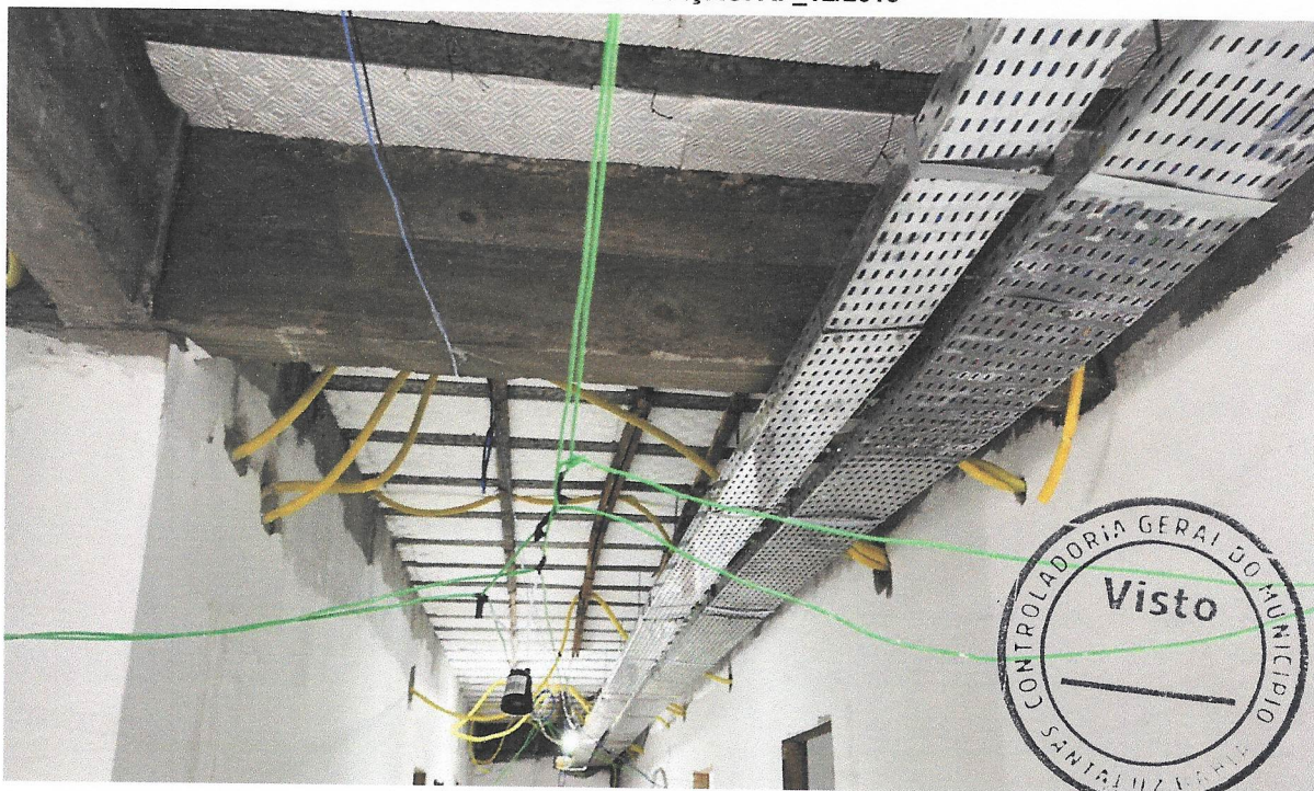
FOTO 46 - ELETRODUTO FLEXÍVEL CORRUGADO, PVC, DN 32 MM (1"), PARA CIRCUITOS TERMINAIS, INSTALADO EM PAREDE - FORNECIMENTO E INSTALAÇÃO. AF_12/2015
