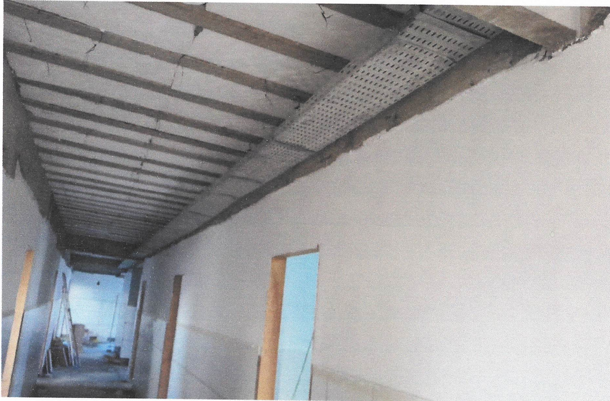
FOTO 24 – APLICAÇÃO MANUAL DE PINTURA COM TINTA LÁTEX ACRÍLICA EM PAREDES, DUAS DEMÃOS. AF_06/2014
