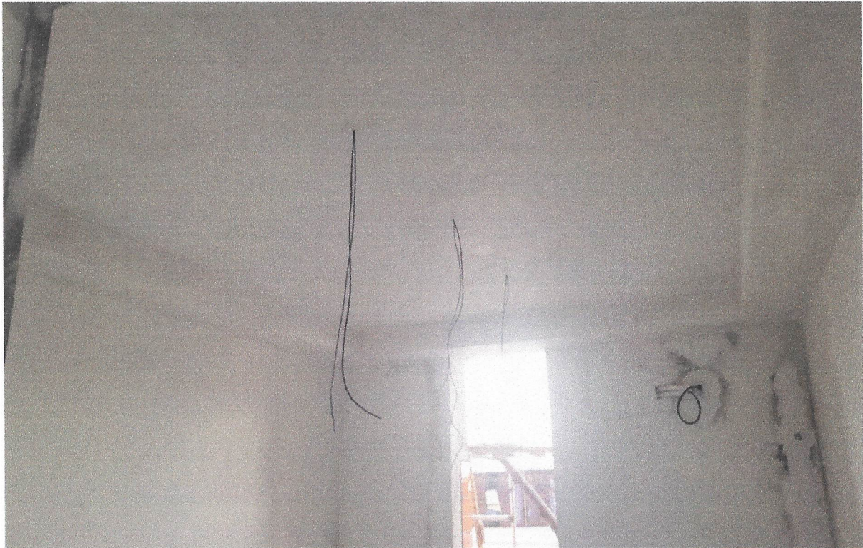
FOTO 22 - FORRO EM PLACAS DE GESSO, PARA AMBIENTES COMERCIAIS. AF_05/2017_P
