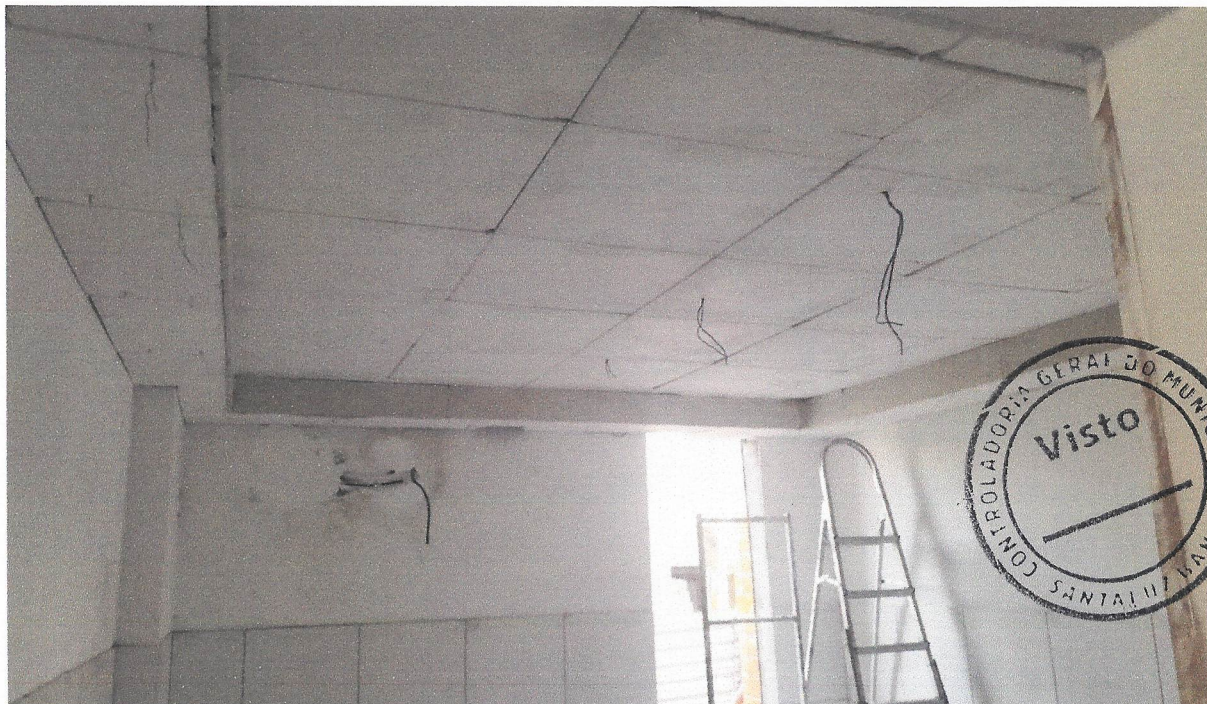
FOTO 22 - FORRO EM PLACAS DE GESSO, PARA AMBIENTES COMERCIAIS. AF_05/2017_P
