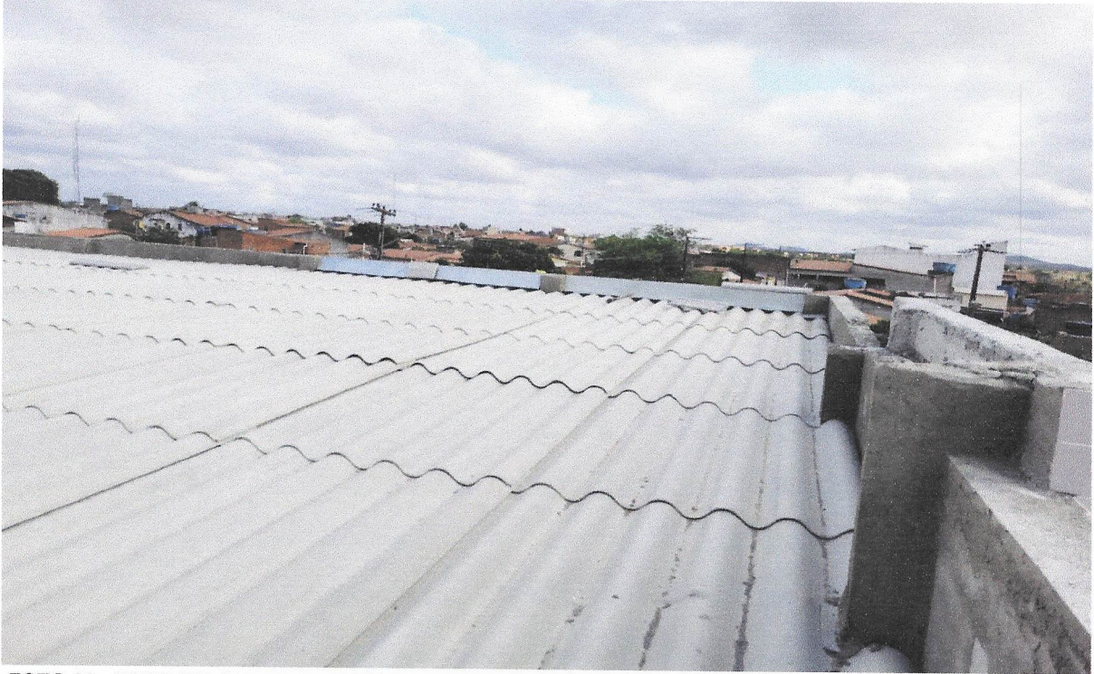
FOTO 32 - RUFO EM CHAPA DE AÇO GALVANIZADO NÚMERO 24, CORTE DE 25 CM, INCLUSO TRANSPORTE VERTICAL. AF_07/2019
