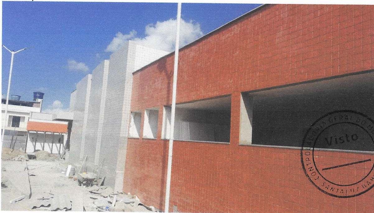
FOTO 14 - PASTILHA CERÂMICA ESMALTADA, 5 X 5 CM, MARCA ATLAS, SÉRIE METALO, COR MÁRMORE - SG8408, APLICADA COM ARGAMASSA INDUSTRIALIZADA AC-II, REJUNTADA, EXCLUSIVE EMBOÇO (OU SIMILAR)
