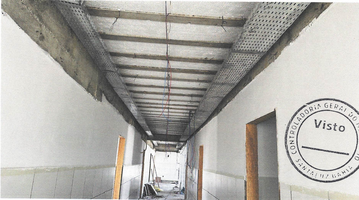
FOTO 44 - CABO DE COBRE FLEXÍVEL ISOLADO, 2,5 MM 2 , ANTI-CHAMA 450/750 V, PARA CIRCUITOS TERMINAIS - FORNECIMENTO E INSTALAÇÃO. AF_12/2015
