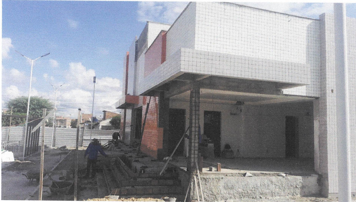
FOTO 14 - PASTILHA CERÂMICA ESMALTADA, 5 X 5 CM, MARCA ATLAS, SÉRIE METALO, COR MÁRMORE - SG8408, APLICADA COM ARGAMASSA INDUSTRIALIZADA AC-II, REJUNTADA, EXCLUSIVE EMBOÇO (OU SIMILAR)
